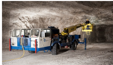
Schritt 3: Das Sprengstofffahrzeug bläst losen Sprengstoff in die Bohrlöcher.
