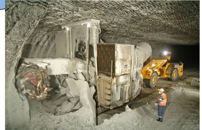
Schritt 1: Der Continuous Miner (CM) schneidet das Salz und lädt es auf das Schiebekastenfahrzeug.
